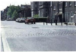
Teilaufpflasterungen mit gepflasterten Rampen und asphaltierter Fahrbahn (Neusser Wall in Köln).
