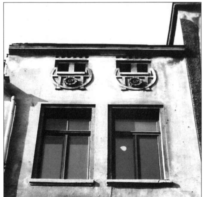
Abb. 191 Olvenstedter Straße 62, Detail
