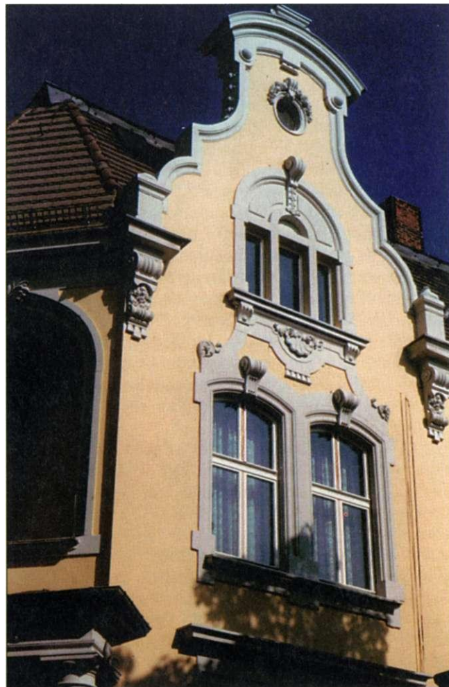
Abb. 173 Maxim-Gorki-Straße 16, Dacherker rechts neben dem Eingang
