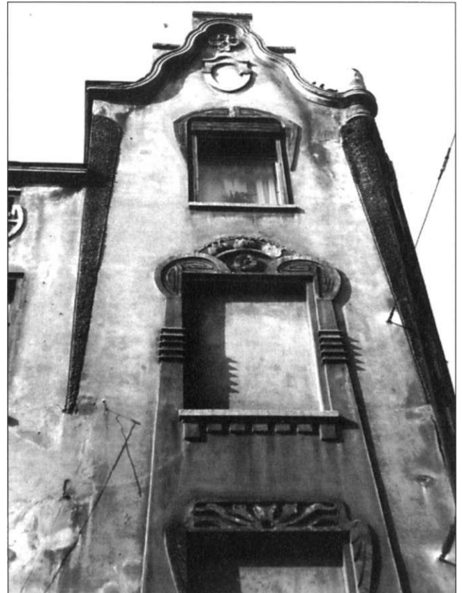
Abb. 190 Olvenstedter Straße 62, Blindfenster mit kantigen Stuckornamenten
