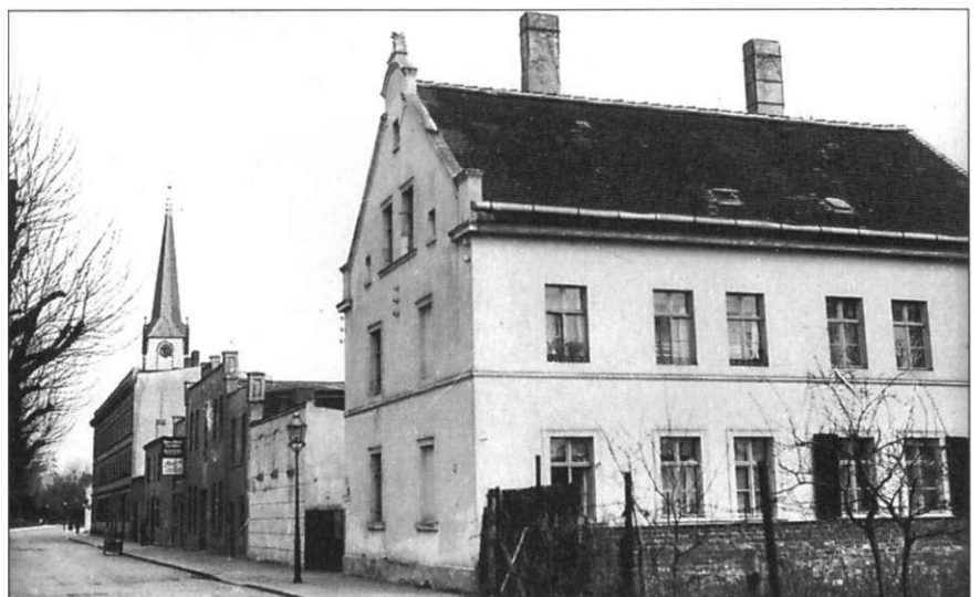
Abb. 215 Alexander-Puschkin-Straße 47, bei Renovierungsarbeiten sind sämtliche Profile mit Ausnahme derjenigen an der Giebelspitze entfernt worden, Aufnahme vom 6. 4. 1940
