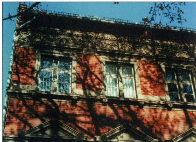
Abb. 165 Olvenstedter Straße 37, Detail des Wohnhauses
