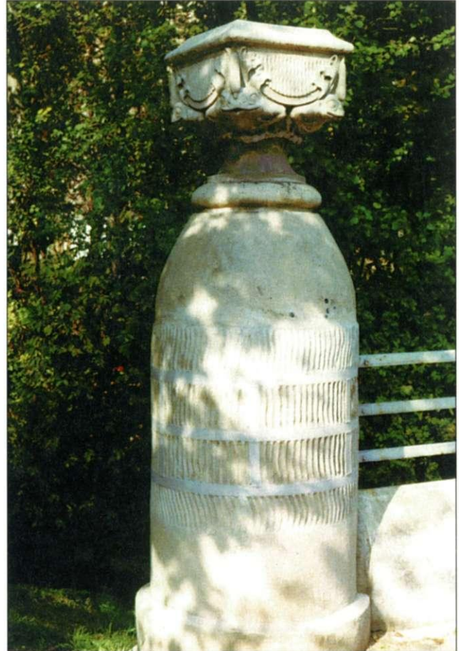
Abb. 214 Brückenpfeiler auf der Höhe Immermannstraße, mit Fröschen geschmückt
