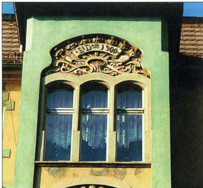
Abb. 182 Große Diesdorfer Straße 15, Teil der Fassade
