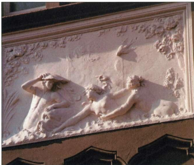
Abb. 153 Details der Fassade des Badehauses
