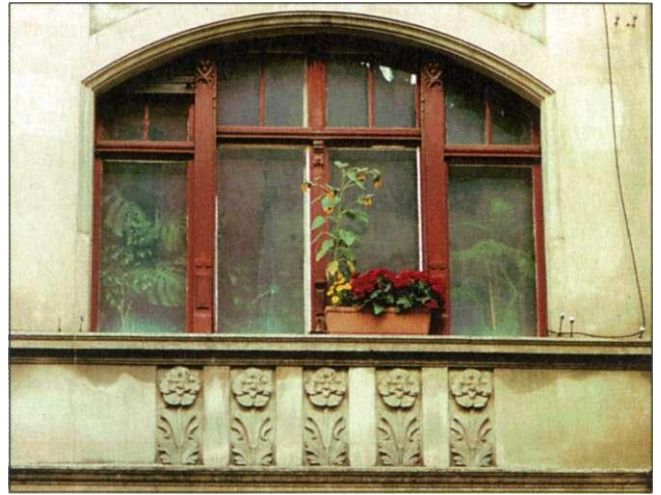
Abb. 196 Alexander-Puschkin-Strasse 26, Fenster im 1. Obergeschoß
