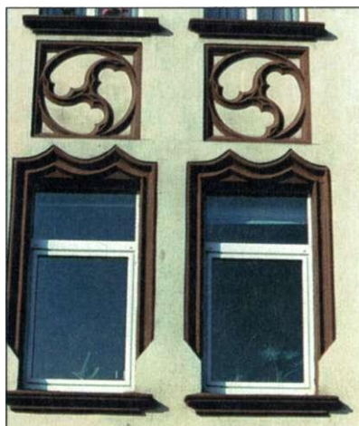
Abb. 148 Steinigstraße 8, Detail, Blendmaßwerk und doppelte Vorhangbögen als Fensterprofile
