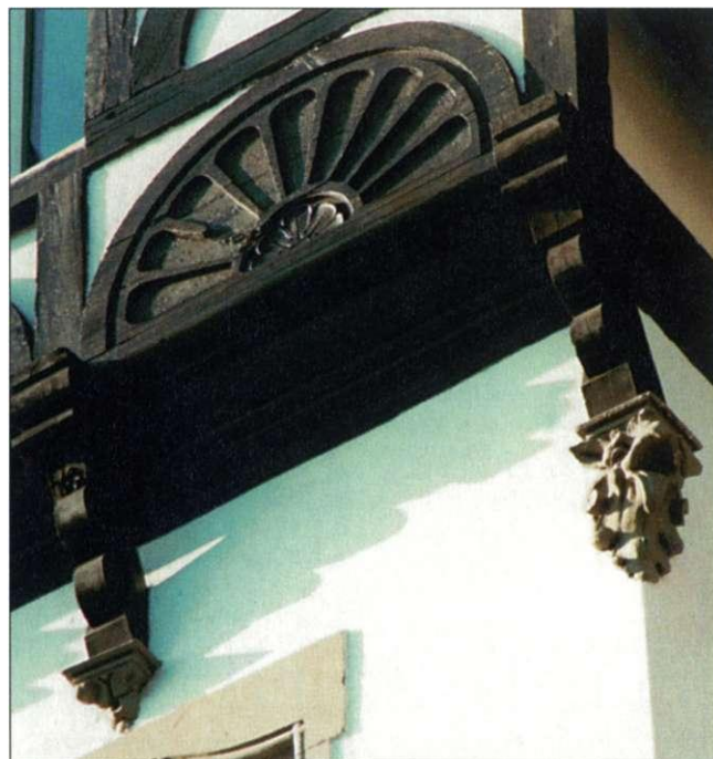
Abb. 152 Details der Fassade des Badehauses
