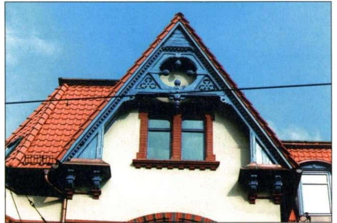
Abb. 158 Große Diesdorfer Straße 5, hölzerne Giebelverdachung am Risalit
