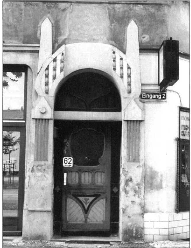
Abb. 186 Olvenstedter Straße 62, Eingang 2 an der Olvenstedter Straße
