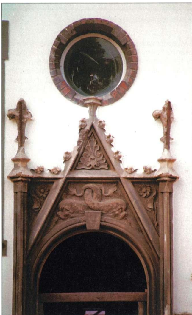
Abb. 154 Details der Fassade des Badehauses
