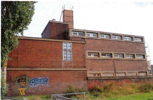
Volksbad Südost mit Büchereizweigstelle, Baujahr 1926, Rückseite und Innenansicht Treppenhaus
