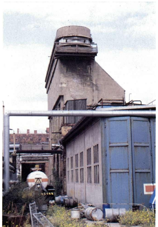
Kohlenbunker auf dem Gelände des Schlacht- und Viehhofes, Baujahr 1924
