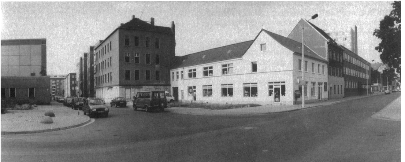
Abb.: Der Kuckhoffplatz - links die Hugenottenstraße, rechts die Haldensleber Straße
