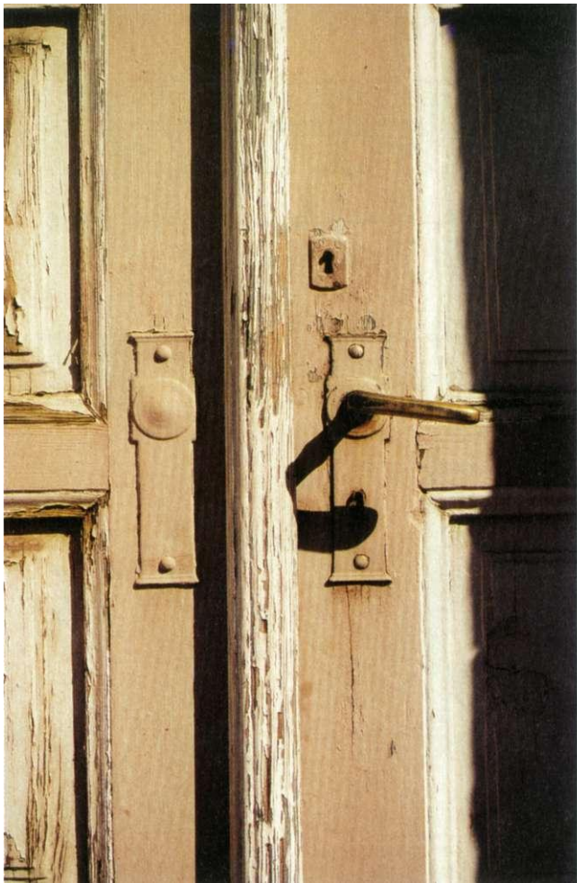
Abb.: Eingangstür des Wohnhauses Ritterstraße 10
