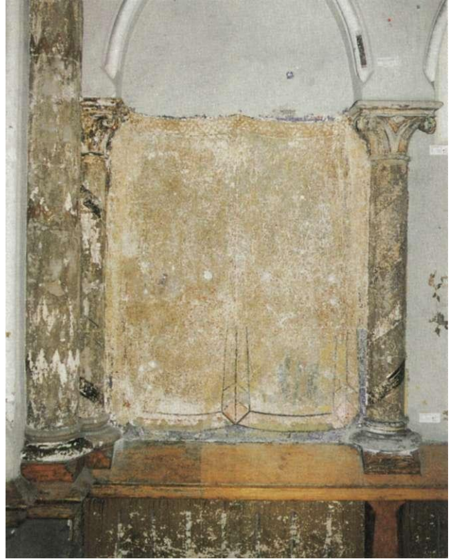
Abb. 131 Sternstraße 29 a Zustand während der Restaurierung im Eingangsbereich. Freigelegtes Feld zur Erstellung einer Probeachse im linken Bereich der Südwand. Säulen, Kapitelle, gemalter Vorhang und Sockel sind freigelegt. Das Feld zeigt Verluste in der Fassung und Schablonierungsfragmente.
