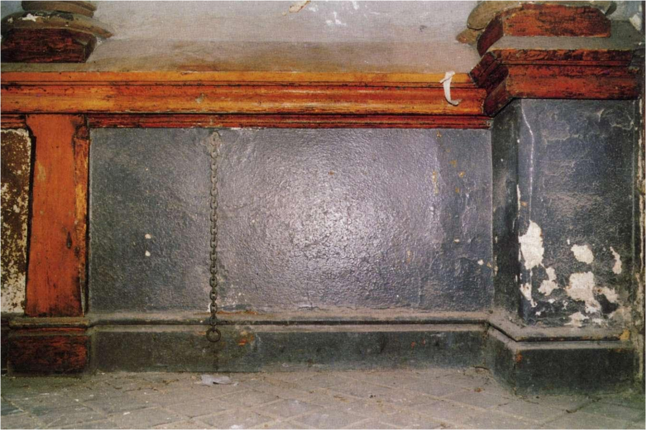
Abb. 122 Sternstraße 29 a Zustand während der Restaurierung im Eingangsbereich; Sockelzone mit freigelegten Gliederungselementen aus Holz, welche in der Ursprungsfassung materialsichtig geblieben sind
