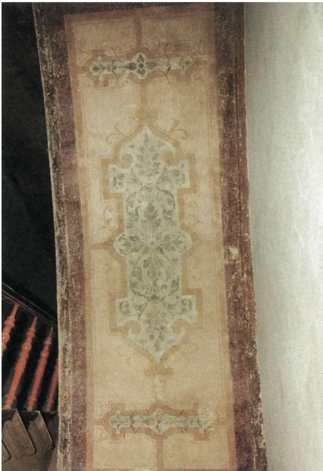
Abb. 129 Sternstraße 29 b Vorgefundener Zustand unterhalb der Kassettendecke im Eingang. Die Schablonenmalerei ist relativ gut erhalten. Die Farbfassung sitzt jedoch sehr locker auf dem Gipsgrund und pudert ab, außerdem ist sie stark mit Staub verschmutzt. Die Abnahme der erheblichen Staubablagerung erfolgte nach einer Testreihe mit frischem Brotteig.
