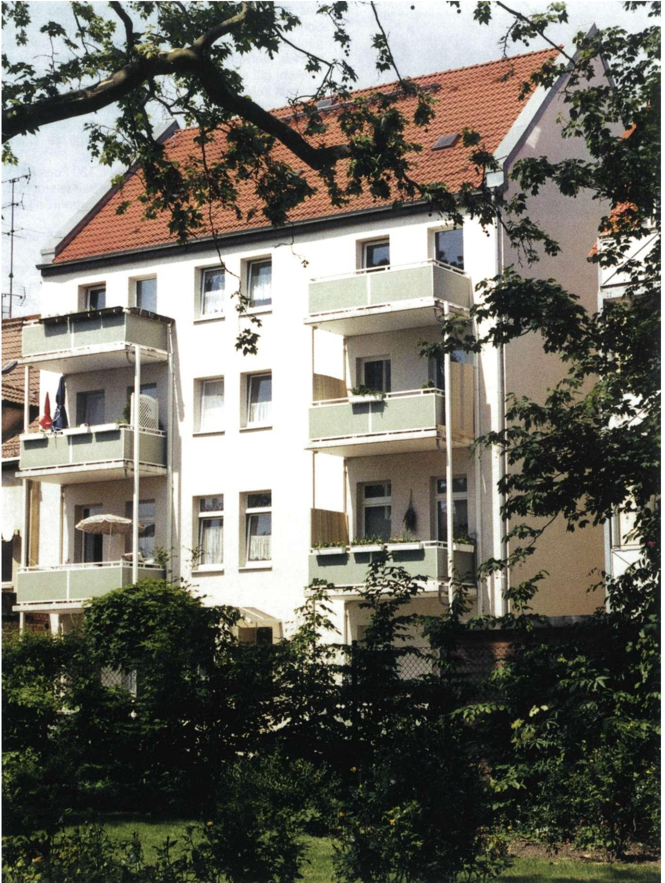
Berberger Straße 16 - Ansicht vom ehemaligen Villenpark
