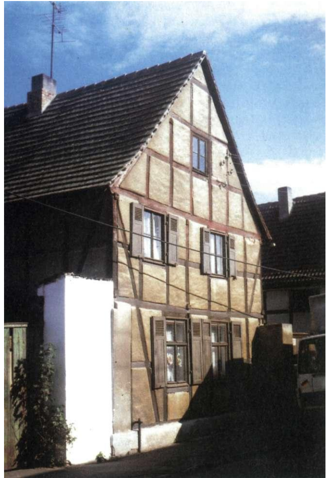
Abb. 8: Hof eines mittleren Bauern (Alt Diesdorf 21)
