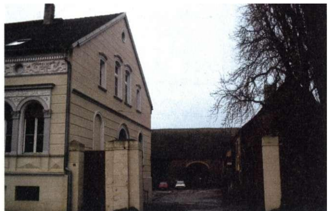
Abb. 12: Hofanlage an der Hemsdorfer Straße
