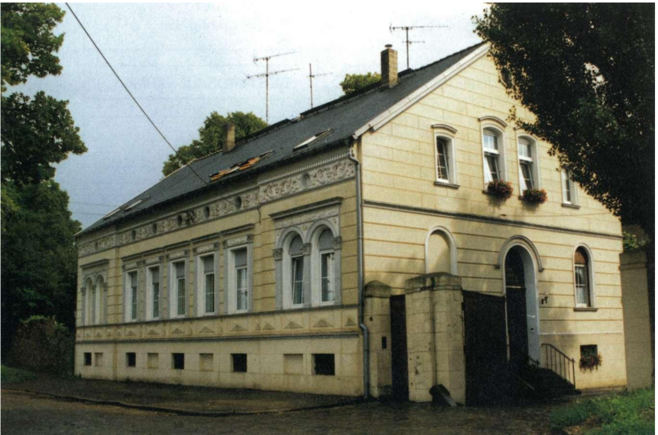
Abb. 8 Bauernvilla Hermsdorfer Straße (Aufnahme Stadtplanungsamt 1996)
