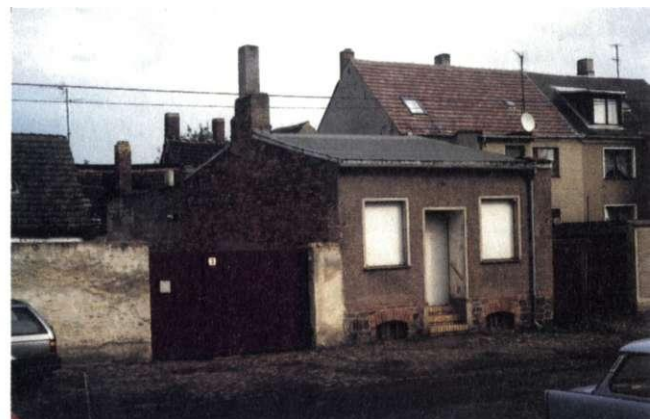
Abb. 10: Wohnbebauung der Landarmut an der Ummendorfer Straße
