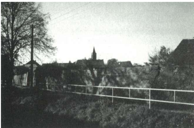
Abb. 27: Mauer entlang der Schrote
