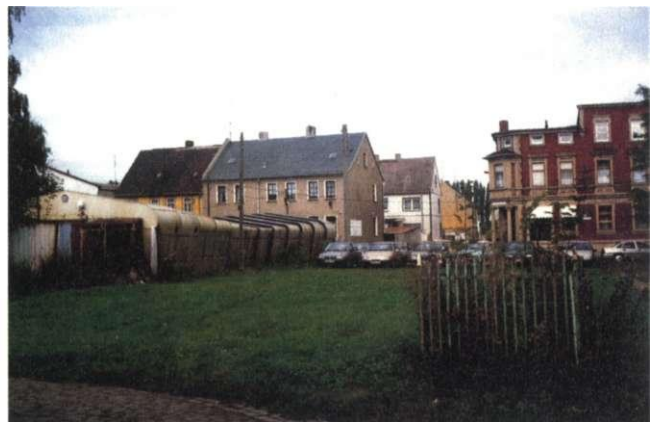
Abb. 30: Pumpe an der Schnarsleber Straße; links im Bild die alte Kaufhalle
