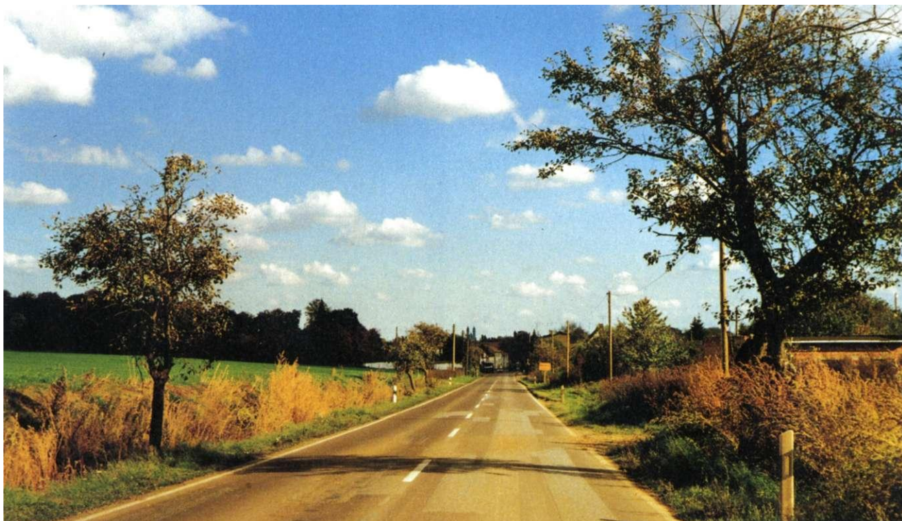
Abb. 31: Ortseingangssituation Niederdodeleber Straße
