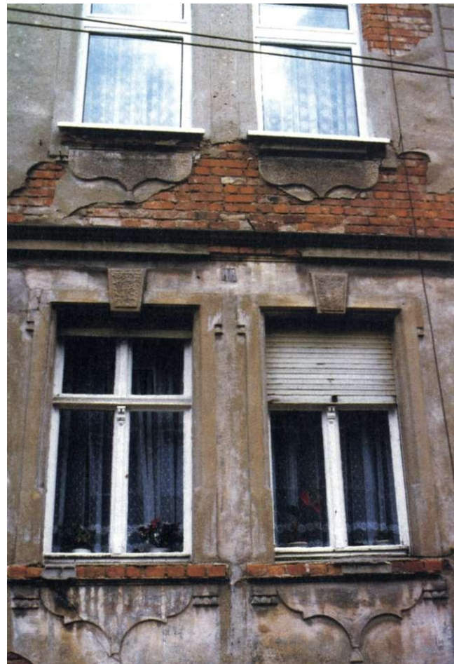
Abb. 25: Fassadenschmuck des späten 19. Jhdts.
