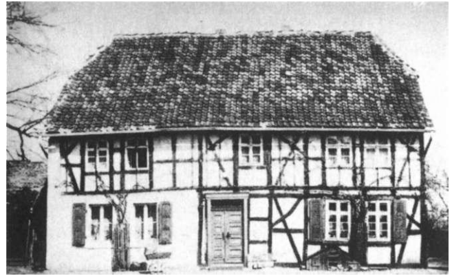
Abb. 22: Wohnhaus eines Großbauern, erbaut um 1800, Klein Rodensieben, Kreis Wanzleben
