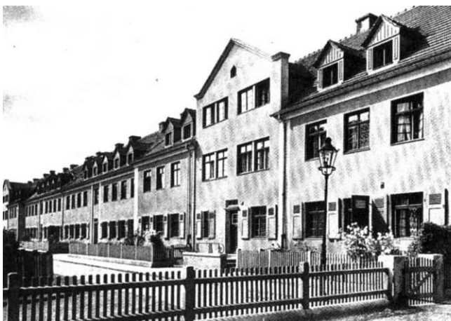
Gartenstadt Westernplan, erbaut von 1923-33, Architekt: Bernhard Lippsmeier
