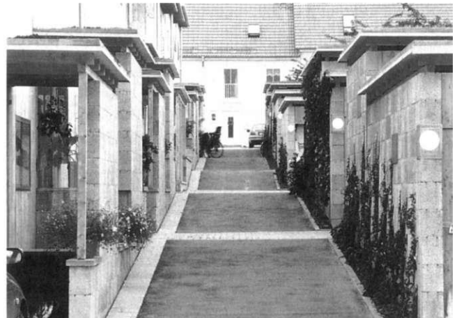
Befahrbare Erschließungsgasse mit Windfängen und Kellerersatzräumen
