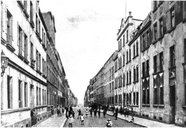
Siedlung Westerhäuser Straße (ab 1927 Otto-Richter-Straße), erbaut 1904-1916 vom Mieter-Bau- und Sparverein
