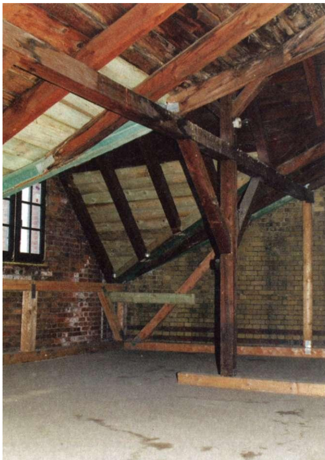
Bauzustand vor der Sanierung
