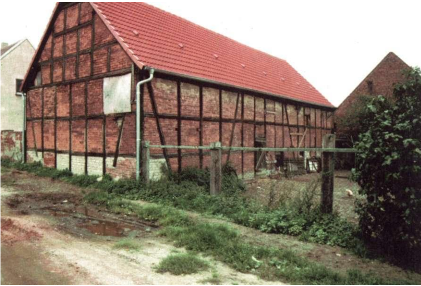
Foto 41: Neu eingedeckte Fachwerkscheune in Pechau
