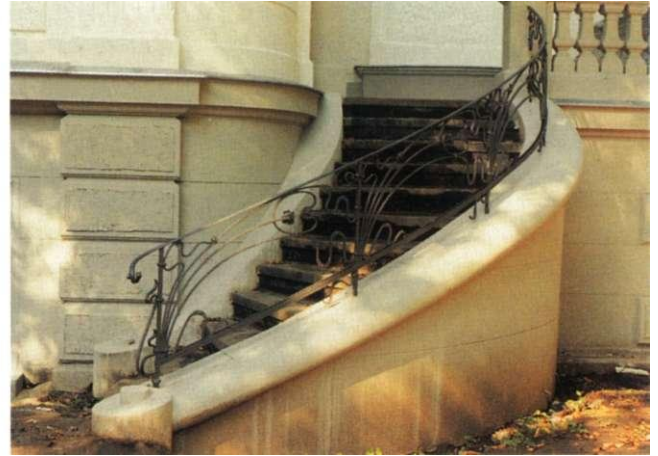
Abb. 125: Lennéstraße 11, Jugendstilgeländer an der Freitreppe
