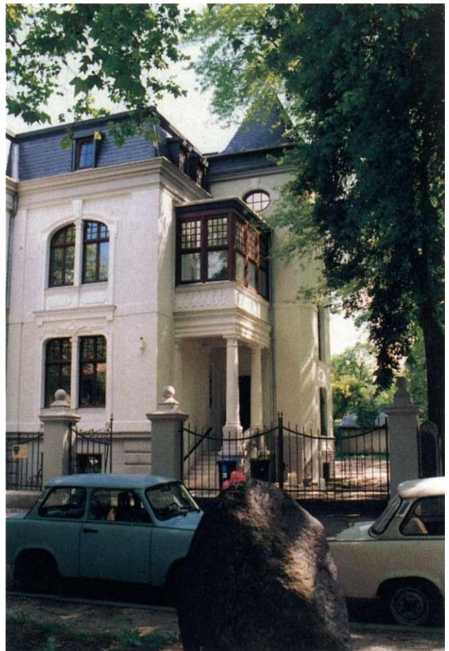
Abb. 123: Lennéstraße 11, Haupteingang an der Westseite
