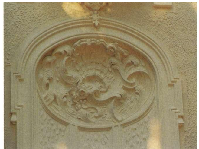
Abb. 124: Lennéstraße 11, Stuckmedaillon an der Gartenfassade
