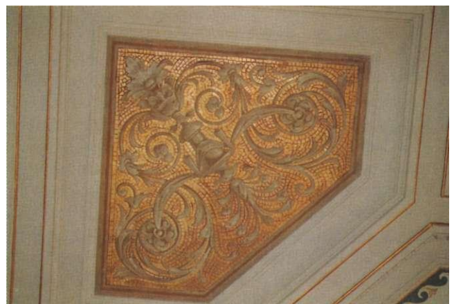
Abb. 121: Humboldtstraße 11, Detail der Deckengestaltung
