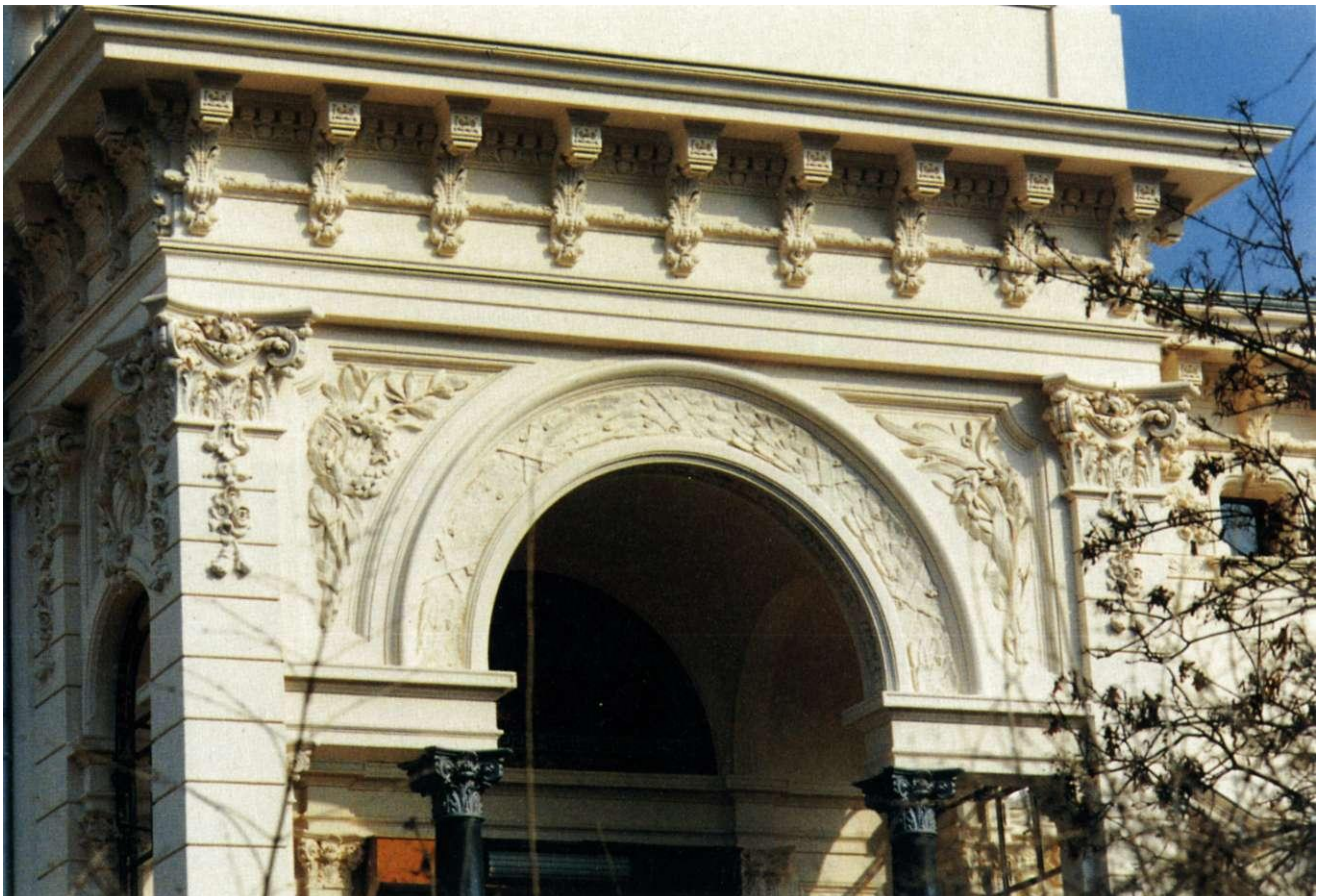
Abb. 28: Kaiser-Otto-Ring 3, Detail der Gartenfassade; die Fassade wirkt durch die mit dem Tageslicht erzeugten Helldunkelwerte am Stuck. Im Kontrast zum hellen Anstrich stehen die schwarzen Granitsäulen der Loggia.
