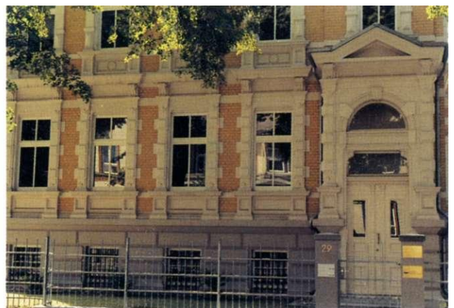
Abb. 25: Klausenerstraße 29, Beispiel für eine denkmalpflegerisch akzeptable Farbgestaltung. Alle Werkstein imitierenden Putzflächen sind in gebrochenem Weiß gefaßt, so daß der Kontrast zum gelben Backstein nicht zu hart wirkt. Der Sockel des Gebäudes ist etwas dunkler in Grau gefaßt, wodurch seine tragende Funktion optisch unterstrichen wird.
