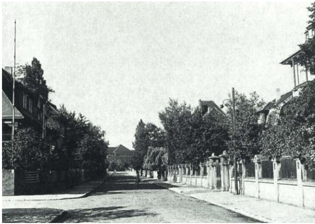
Abb. 36: Eichendorffstraße von Norden gesehen, Aufnahme vom 2.7.1943
