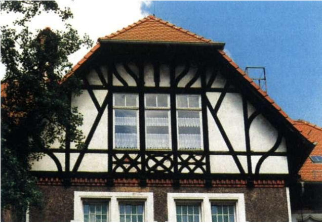
Abb. 21: Lennestraße 1, aufwendige Fachwerkkonstruktion am Giebel
