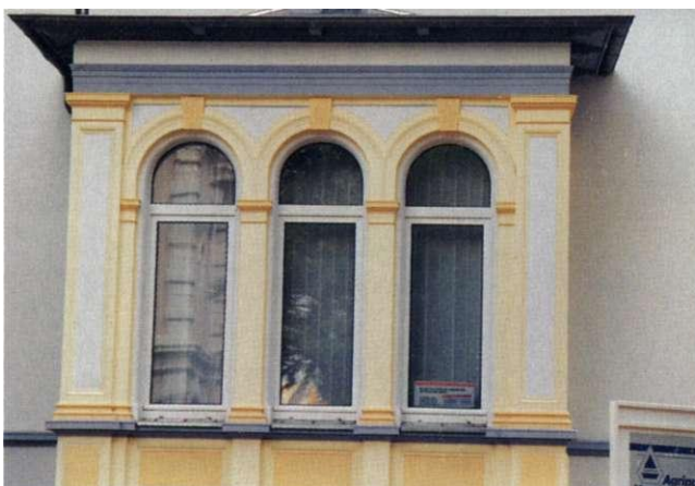
Abb. 24: Klausenerstraße 18, Beispiel für eine ungeeignete Farbrestauration. Die einzelnen Elemente des Fassadenschmucks sind farblich in Gelb, Orange, einem hellen und einem dunklen Graublau abgesetzt. Hierdurch geht die Einheitlichkeit der Fassade verloren und wird die Reliefwirkung der Schmuckelemente gestört. Die Villa wirkt wie eine mit Zuckerguß überzogene Torte.
