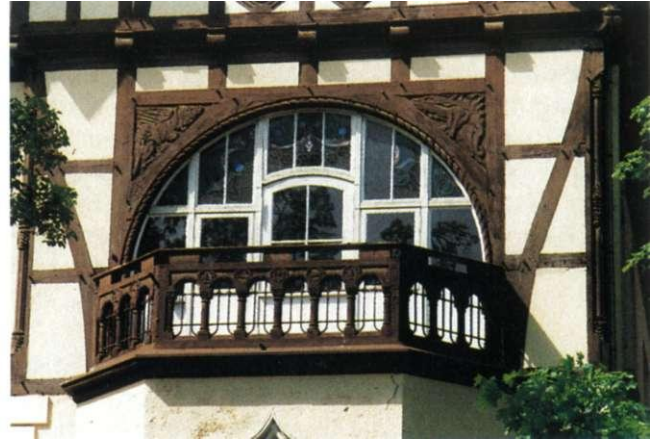
Abb. 22: Humboldtstraße 1, Detail, aufwendige Holzarbeiten an der Außenfassade
