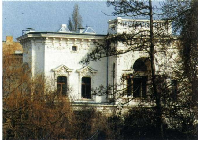
Abb. 27: Kaiser-Otto-Ring 3, Blick auf die Gartenfassade; der Anstrich ist etwas zu hell gewählt, so daß das Gebäude bei starker Sonneneinstrahlung blendet und die Ornamentik an Plastizität verliert.
