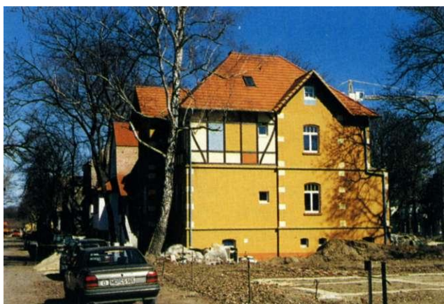
Abb. 30: Eichendorffstraße 4, 1907, die orange Fassade mit gelb abgesetzten Rechtecken und mehrfarbigen Fachwerkfächern erinnert eher an Farbexperimente der Bauhauszeit als an die Farbigkeit der späten historisierenden Phase.
