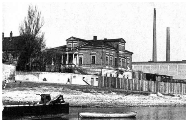
Abb. F: Alte Aufnahme der Kieler Straße 5 vom 1.5.1942, Blick von der Elbe; Das Gebäude stammt aus dem Jahr 1891 und wurde von dem Bauunternehmer Fr. Schmidt auf dem Gelände der Schiffsbauwerft W. Gerloff errichtet; Inzwischen ist das Gebäude verändert und droht zu verfallen, bzw. abgerissen zu werden
