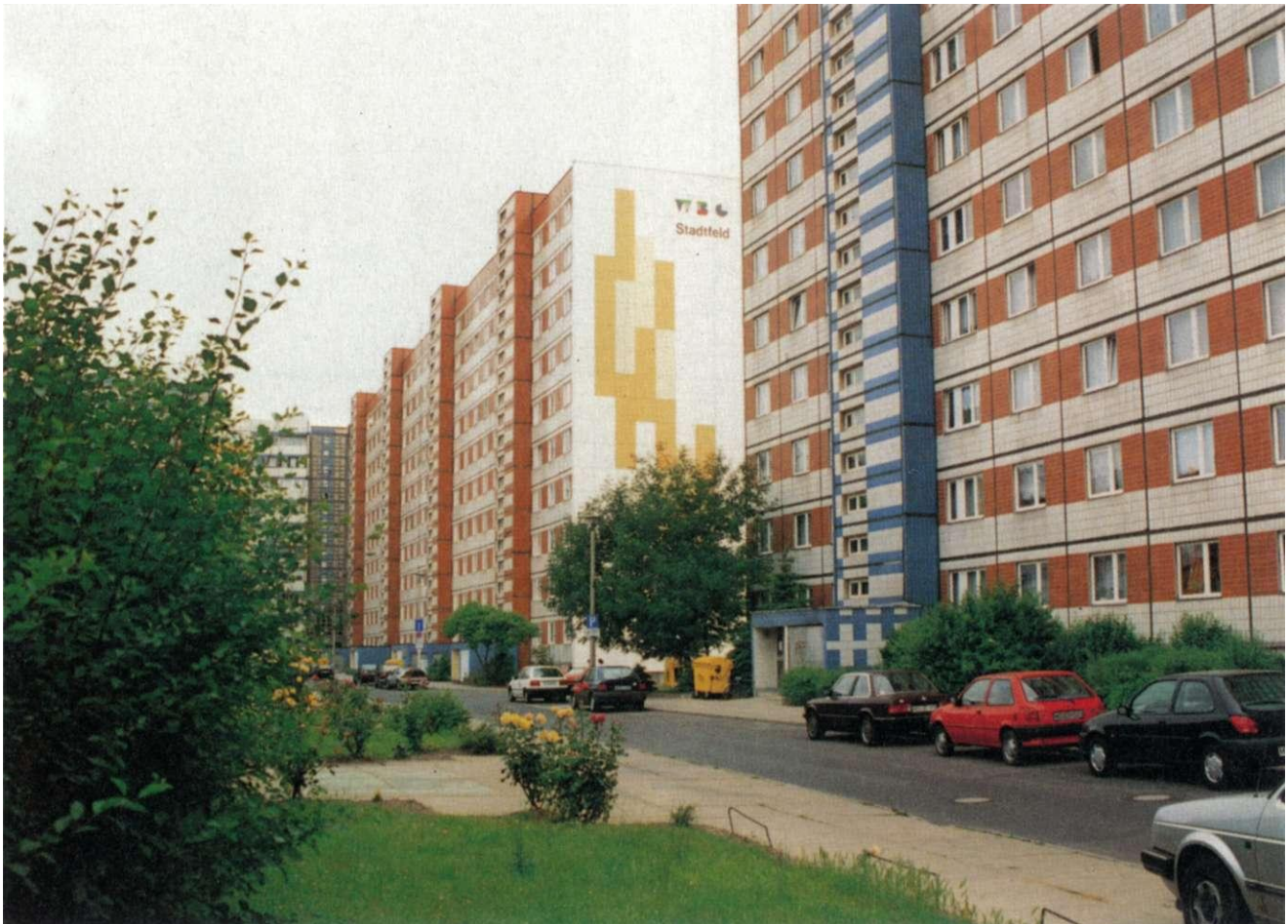
Modernisierter Plattenbau „Typ WBS 70“, Lumumbastraße 21-24
