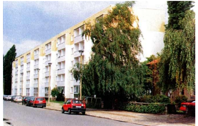
Fermersleber Weg 22-36 (Baujahr 1970)
