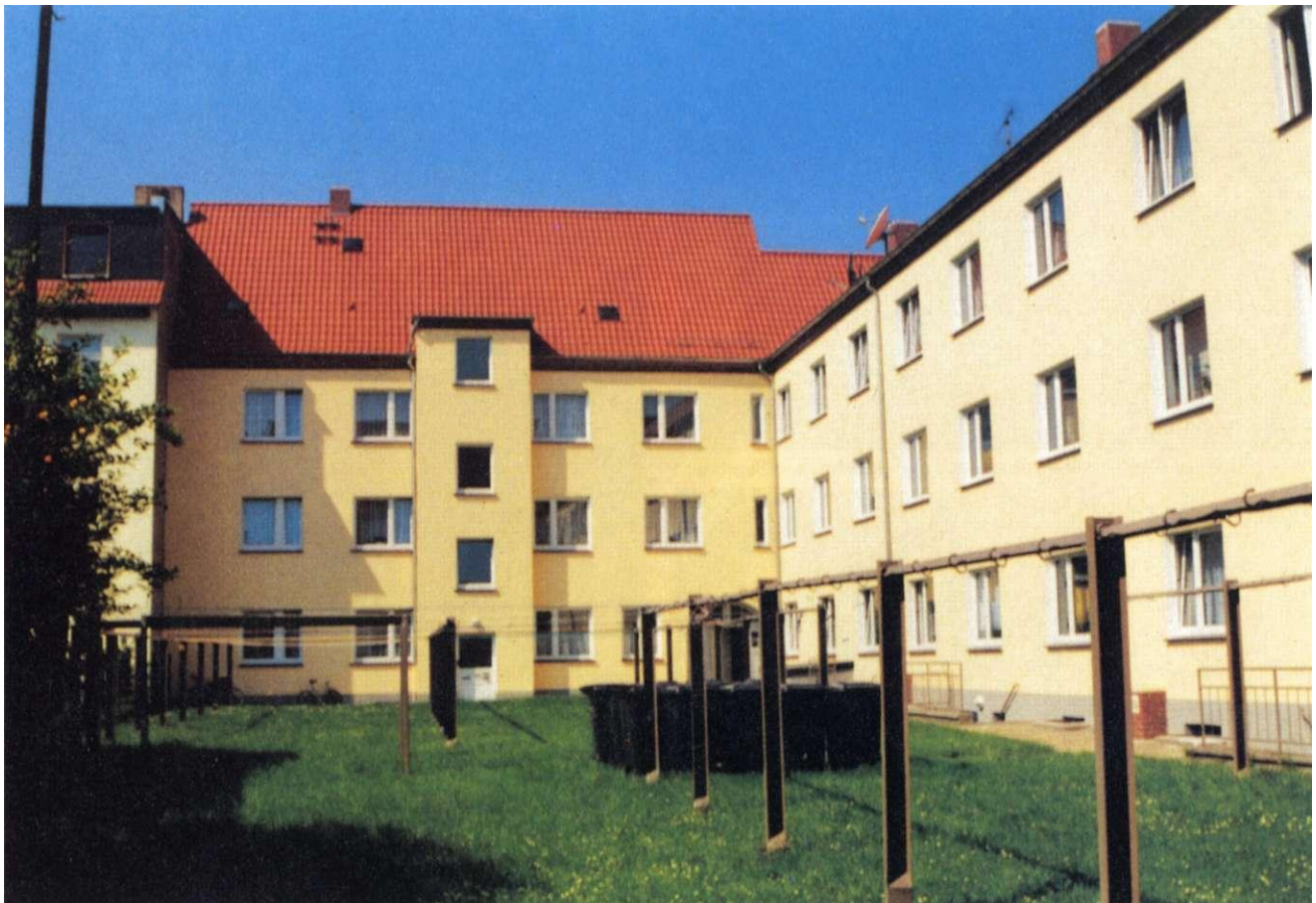
Innenhof Alt-Fermersleben 10 + 10a
