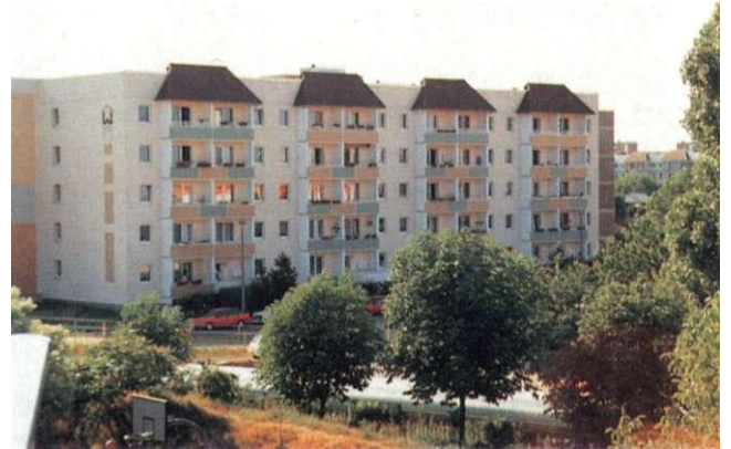
Silberschlagstraße in Neustädter Feld Baujahr 1982, Modernisierung 1995
