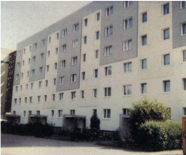
Ferdinand v. Schill Straße 25-31 Neue Fassadengestaltung
