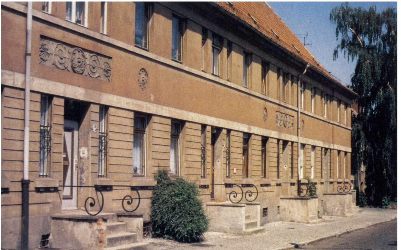
Hauseingänge am „Sechserblock“ Barbarastraße 5-10 Heutiger Zustand
