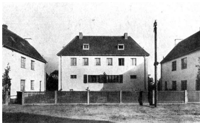
Mehrfamilienhaus in der Cäcilienstraße 1926, Entwurf: Stadterweiterungsamt
