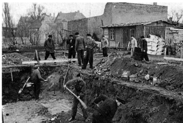
AWG „Örtliche Wirtschaft“, Schachtarbeiten in der Moselstraße
