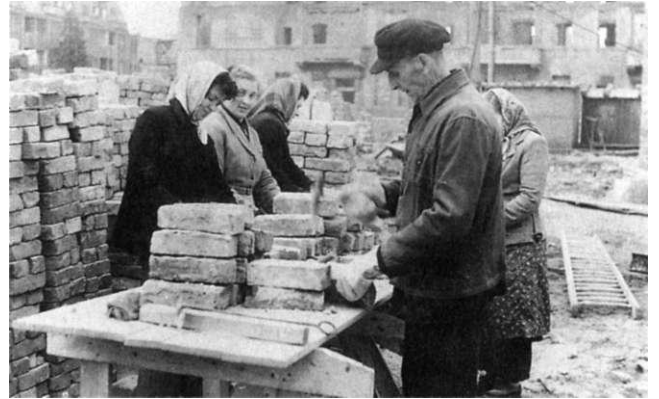
AWG „Deutsche Reichsbahn“, Abputzen der Trümmerziegel zur Wiederverwendung
