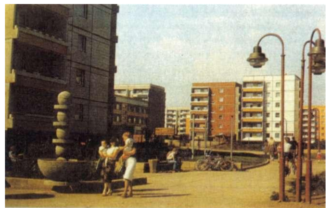
1. Bauabschnitt Neu-Olvenstedt, Bereich am Parkweg
