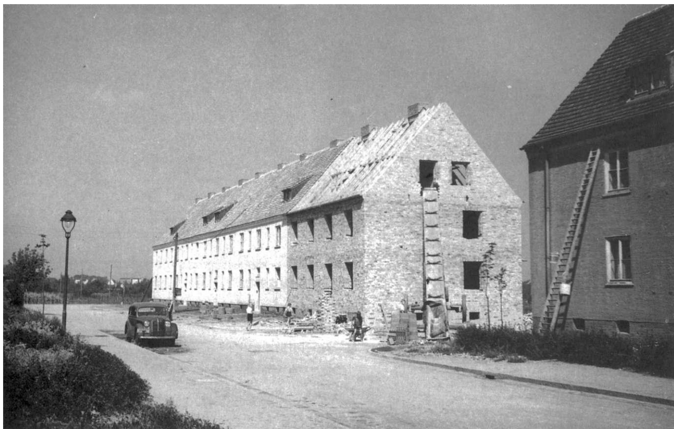
Lindenhof-Siedlung. Wiederaufbau eines zerstörten Hauses. (Foto: StAM) ▼
