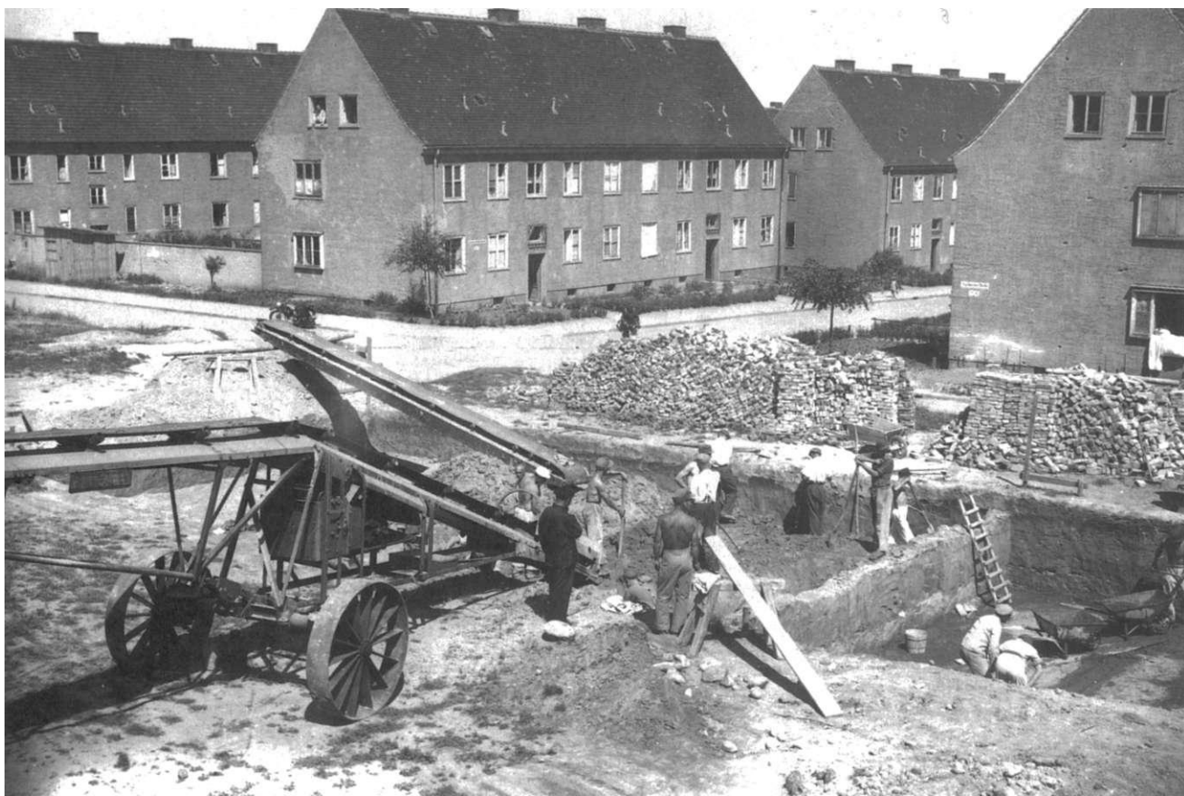
Lindenhof-Siedlung. Ausschachtungsarbeiten für die Bebauung von 1950. (Foto: StAM) ▲
