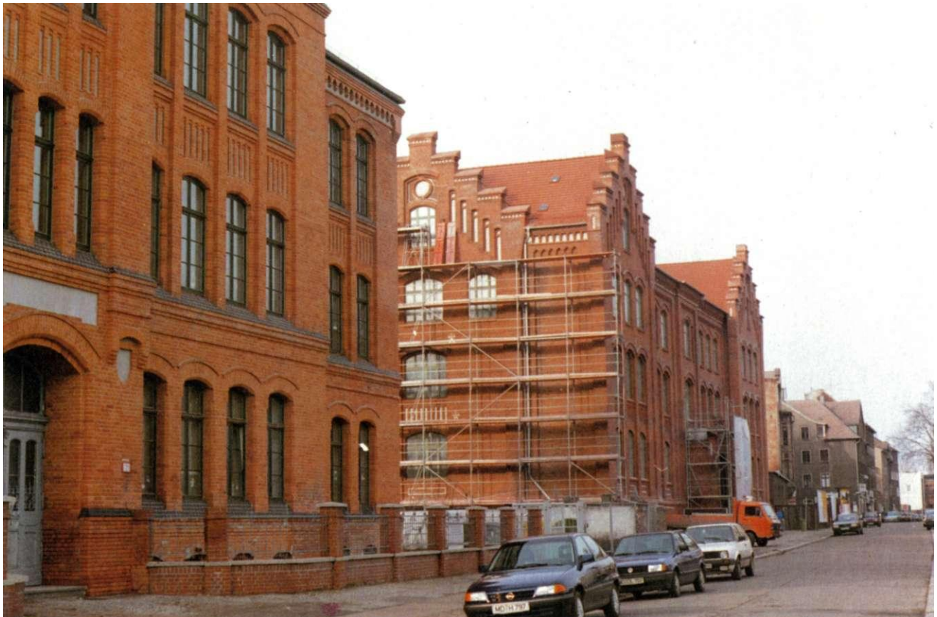
Sanierte Schulen in der Karl-Schmidt-Str.
