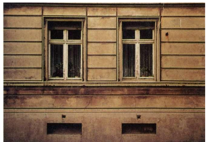
Typische Fassaden- und Fenstergliederung
