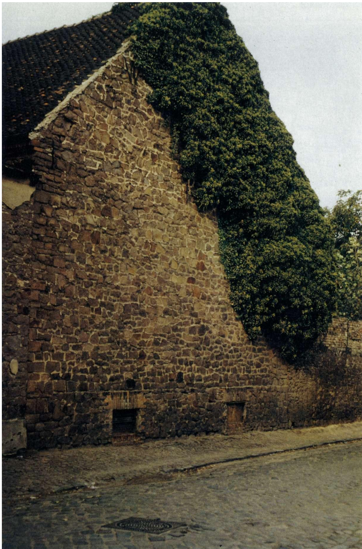
Bruchsteingiebel in der Dorfstraße
