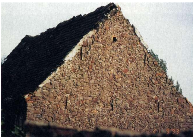
Grauwacke, ein vielfach verwendetes Baumaterial in Olvenstedt
