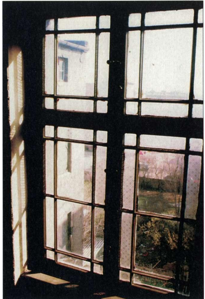
Abb. 136 Annastraße 34, vierteilige Treppenhaufenster
