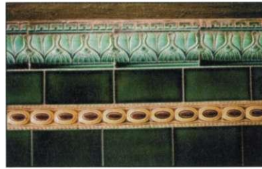
Abb. 149 Wandfliesen im Eingang, Wilhelm-Kobelt-Straße 18
