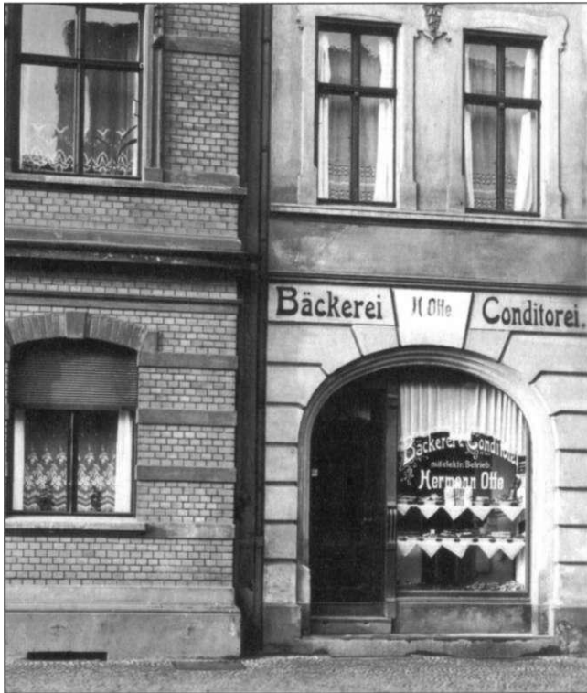
Abb. 131 Westring 10 und 12, Detail der Fassade, Aufnahme vom 13.11.1935
