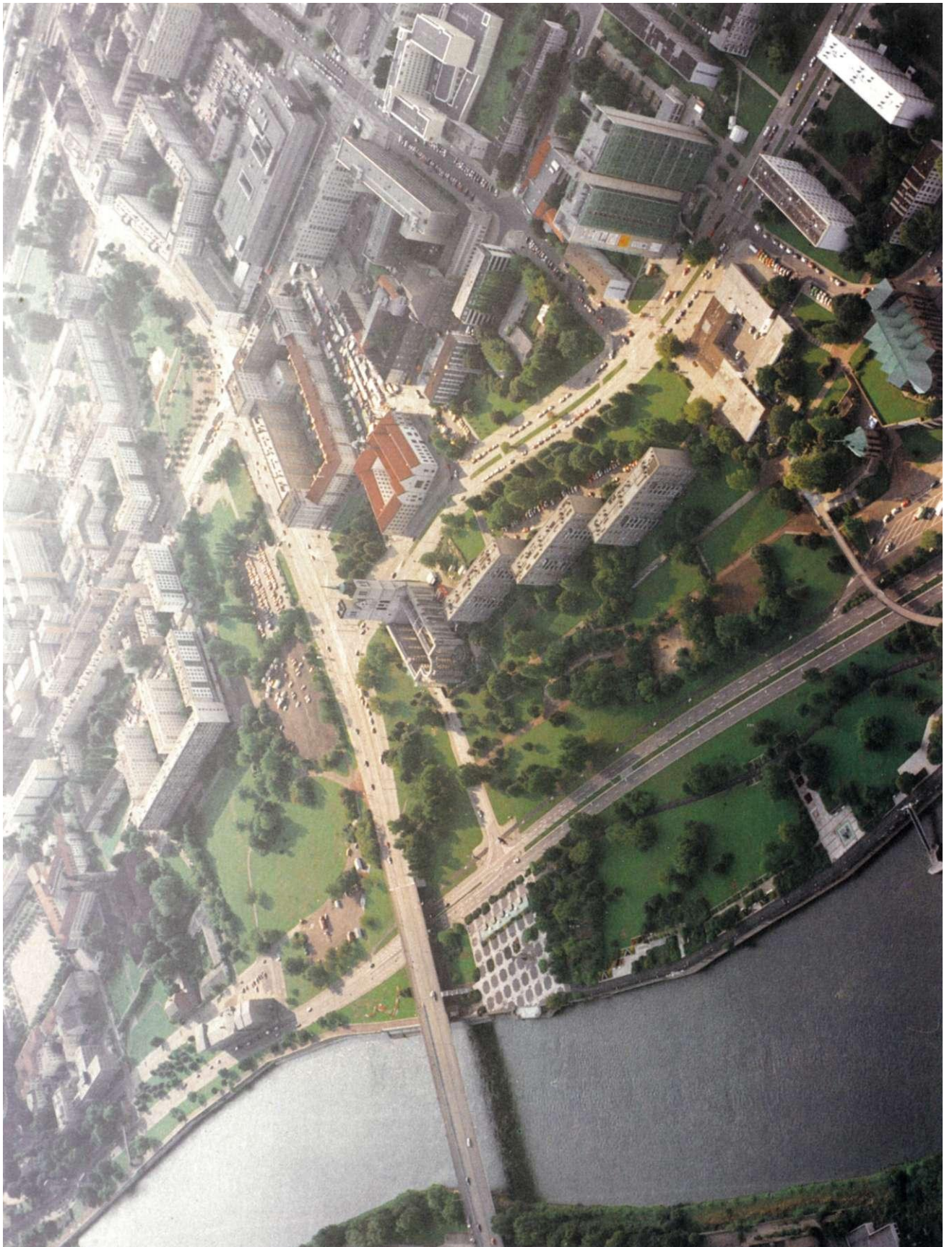
Das Elbufer zwischen Petriförder und Kiek in de Köken
