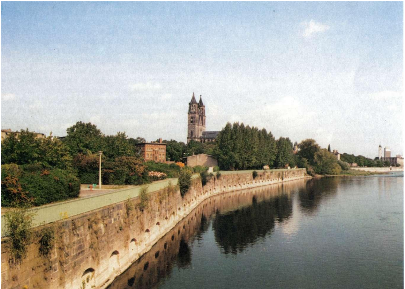
Abb. 183 Blick von der Hubbrücke in Richtung Norden
