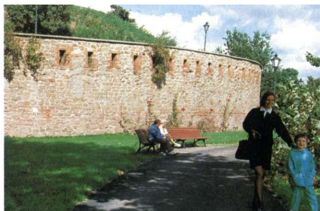
Abb. 175 Reste der Befestigungsmauer mit Maulscharten
