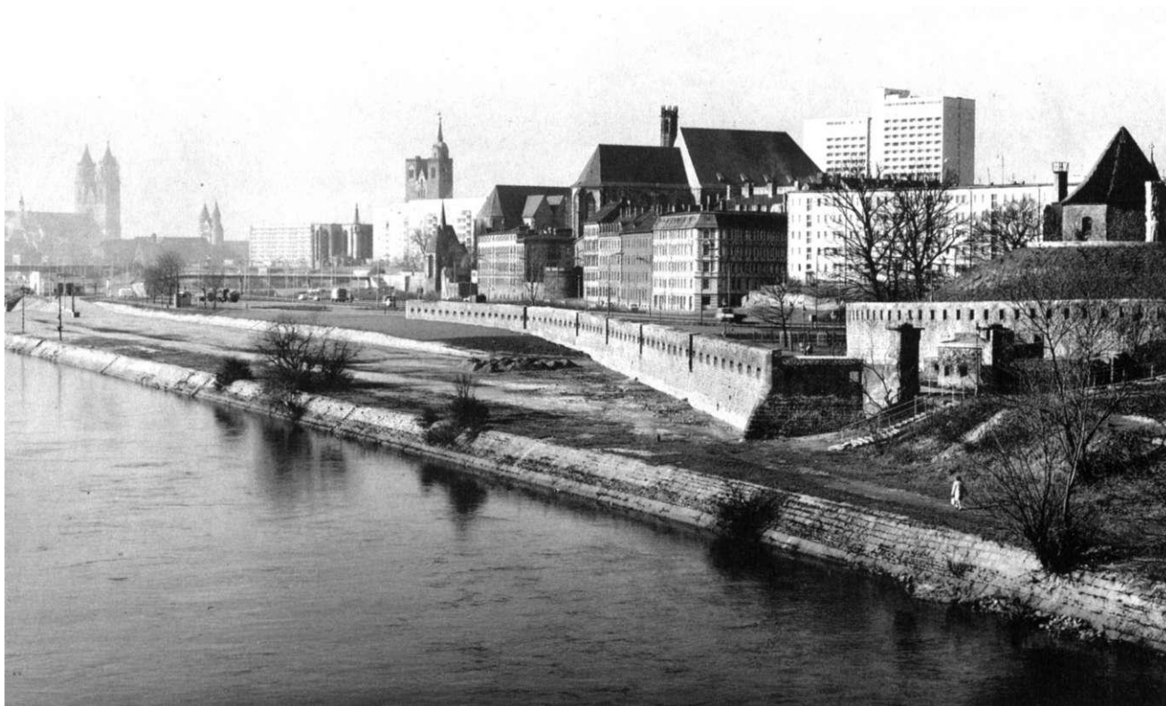
Abb. 177 Bauarbeiten um 1973, im Vordergrund das nördliche Eisenbahntor
