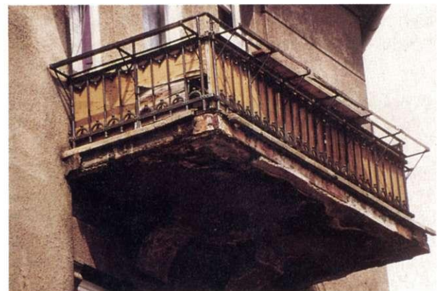
Abb. 28: Wohnhaus Eckgrundstück Jordanstraße | Dürerstraße
