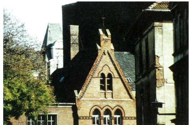
Blick auf das ehemalige Wohn- und Stallgebäude Braunschweiger Straße 6 (im Hintergrund eine Villa in der Klausenerstraße)
