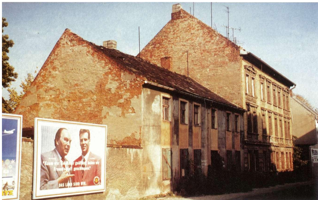
Blick in die St. Michaelstraße auf das Haus Nr.21 / 21a
