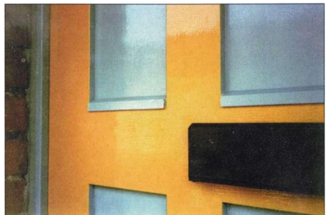
Detail einer restaurierten Tür aus dem Lilienweg.
