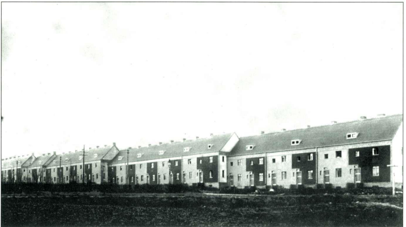
Die plakative Rhythmik und farbenfrohe Gestaltung der Fassadenelemente sind das deutlichste Merkmal auf der Westseite der Straße „Zur Siedlung Reform“.
