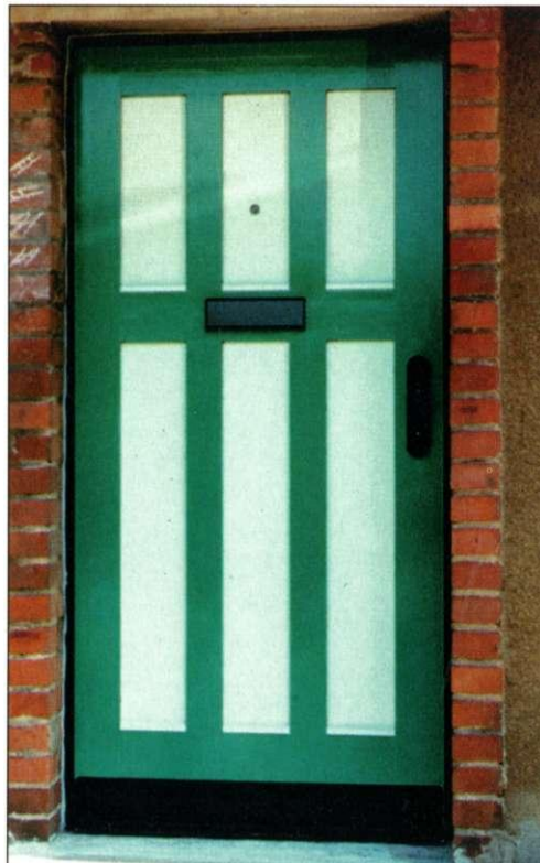
Beispiel für eine sanierte Tür
