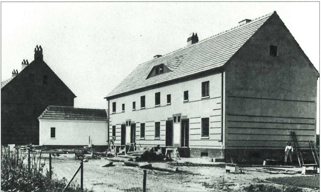
Stark geometrische Muster auf den Putzflächen sind für die dritte Bauphase, Bruno Taut typisch. Dazu kommen vielgestaltige Spaliere und horizontale Klinkerbänder.
