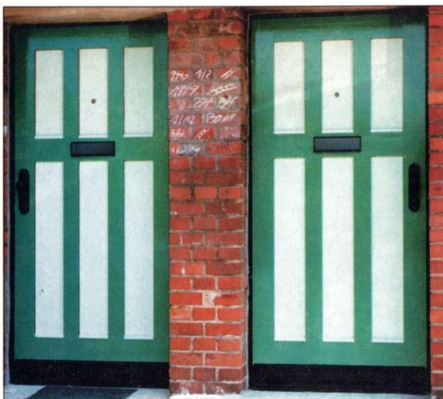
Türen aus dem Bunten Weg nach der Rekonstruktion
