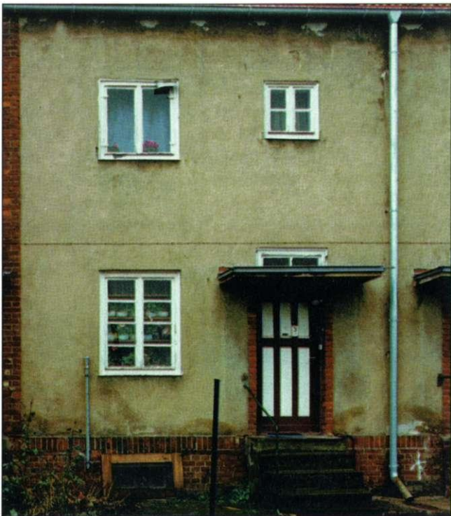
Viele Fenster, wie hier die in den Häusern aus der vierten Bauphase Bruno Tauts in der Brenneckestraße, sind bereits ausgewechselt worden. Einige ältere Fenster zeigen, wie es zukünftig wieder aussehen sollte. Im linken Haus sind noch die Originalfenster mit den Sprossen zu erkennen. Das rechte Haus hat dagegen neue Fenster erhalten.
