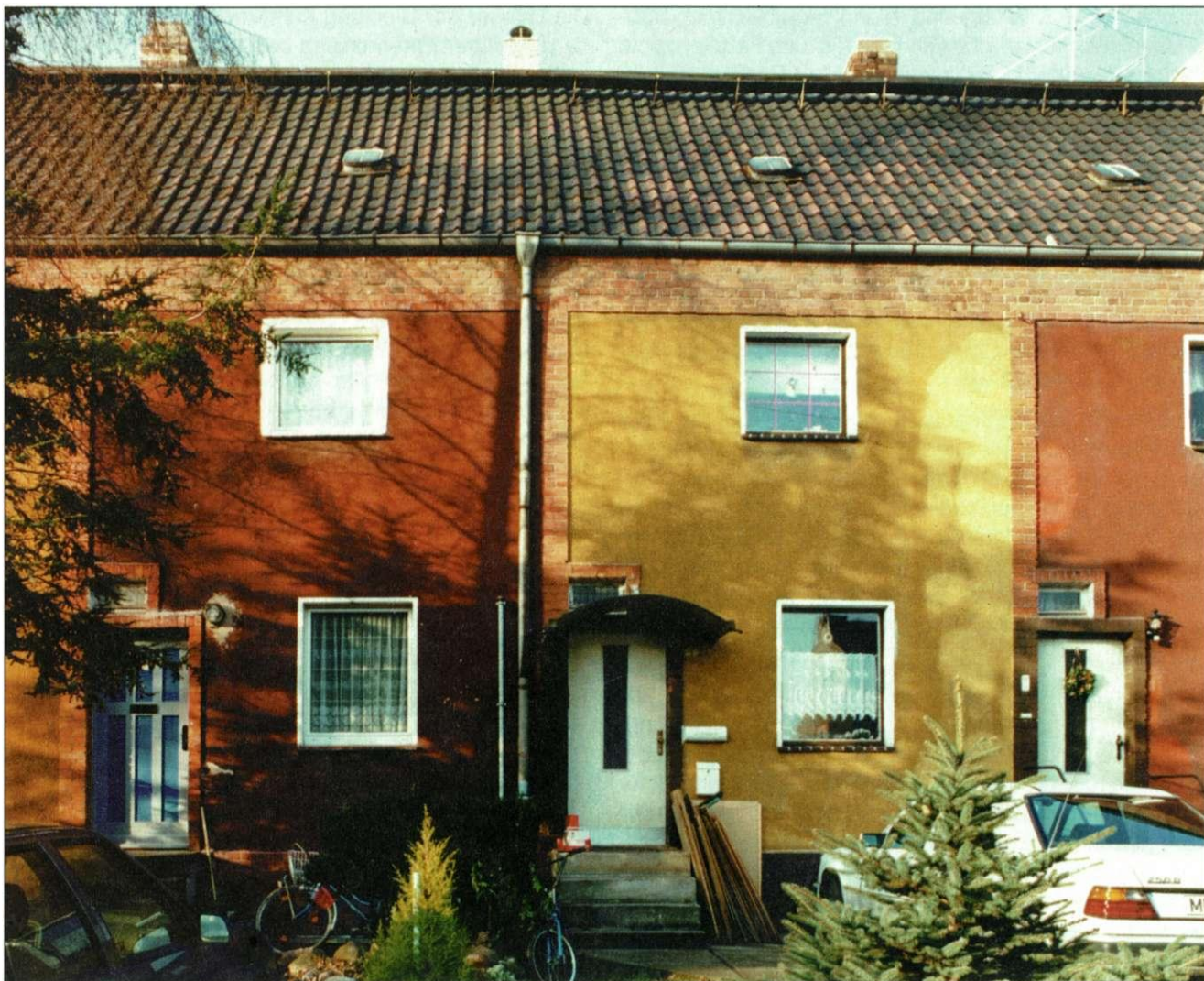
In der dritten Bauphase ist die Gesamtfläche der Fassade wichtig. Farbigkeit und zusammenfassende Materialbänder behalten bei der Gestaltung ihre Bedeutung.
