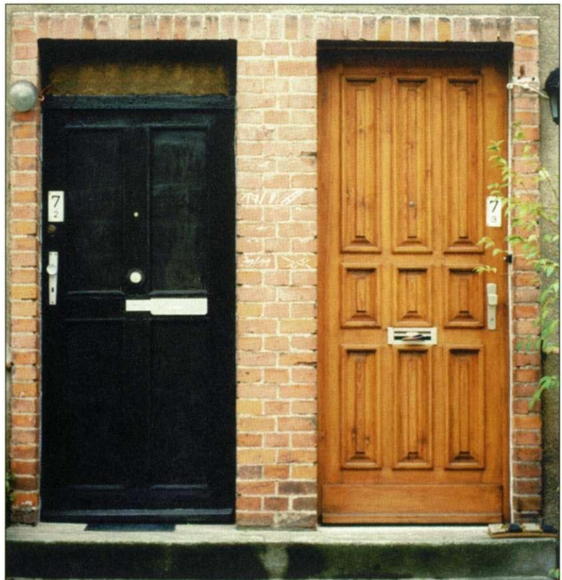
Folgen sicherlich gut gemeinter aber nicht fachgerechter Rekonstruktionsmaßnahmen im Heckenweg.
