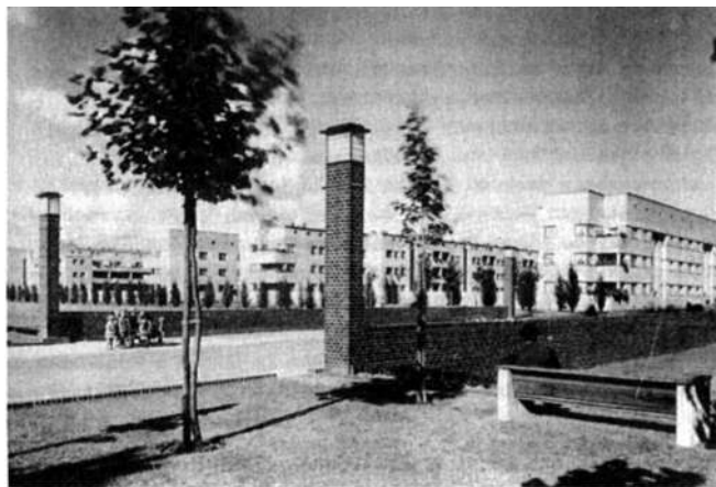
Siedlung Große Diesdorfer Straße um 1929 Photo: Stadtentwicklung und Wohnumfeld. a.a.O. S. 189
