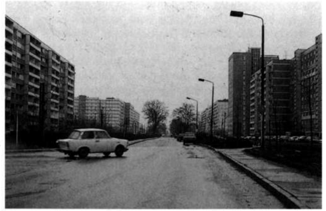
Großsiedlung Neustädter See aus den 70er Jahren, Barle- ber Straße nach Süden Photo: eigene Aufnahme von 1991
