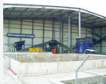
■ Mineralgemischanlage zur Aufbereitung von Fluss- und Hafenschlamm
