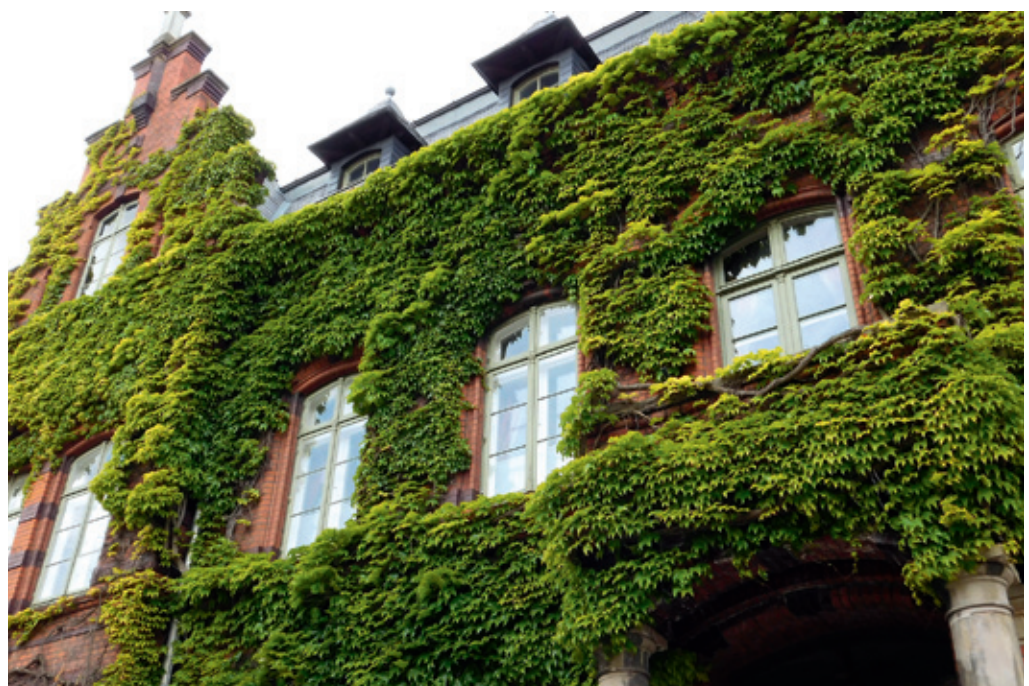
Begrünte Fassade an einem Stadthaus
