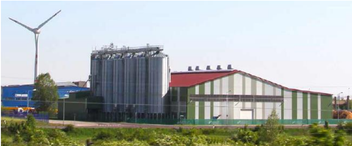
Abbildung 34 Biomasseheizkraftwerk der BioPellet Magdeburg GmbH & Co. KG Quelle: Quelle: [GETEC 2016]
