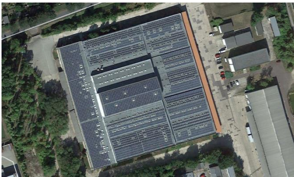
Abbildung 35 PV-Dachflächenanlage auf UPS Depot Quelle: [Google Earth 2017]
