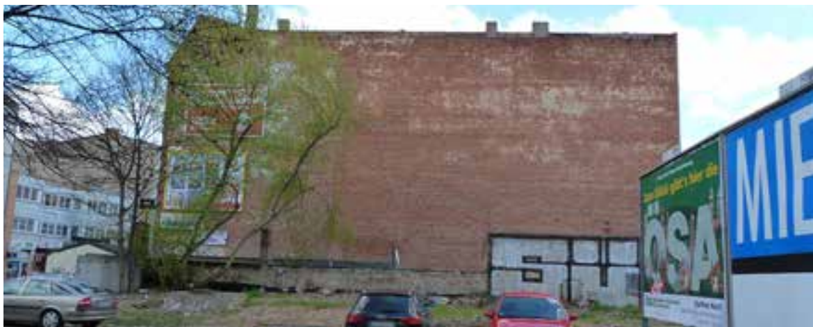
Abbildung 96: Brandwand Große Diesdorfer Straße/Annastraße
