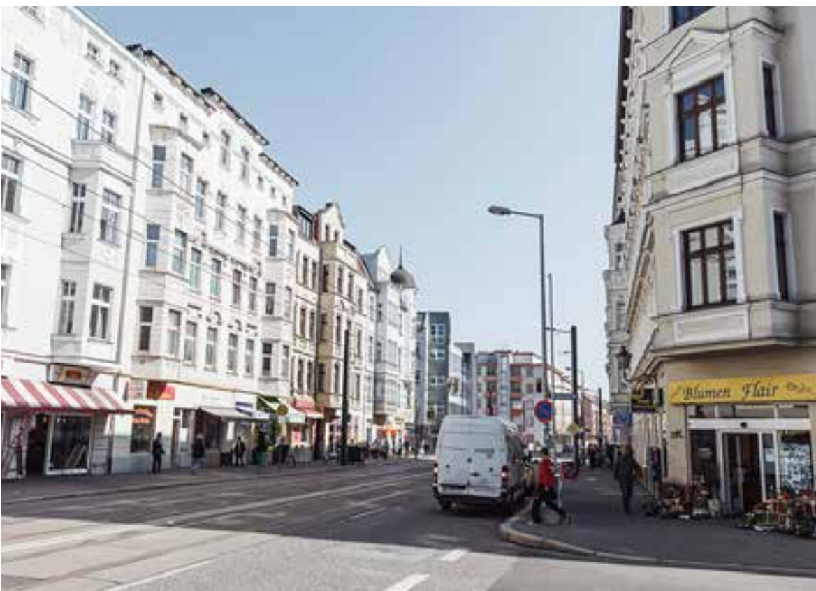
Abbildung 8: Stadtteilzentrum Große Diesdorfer Straße, Höhe Matthissonstraße in Stadtfeld Ost
