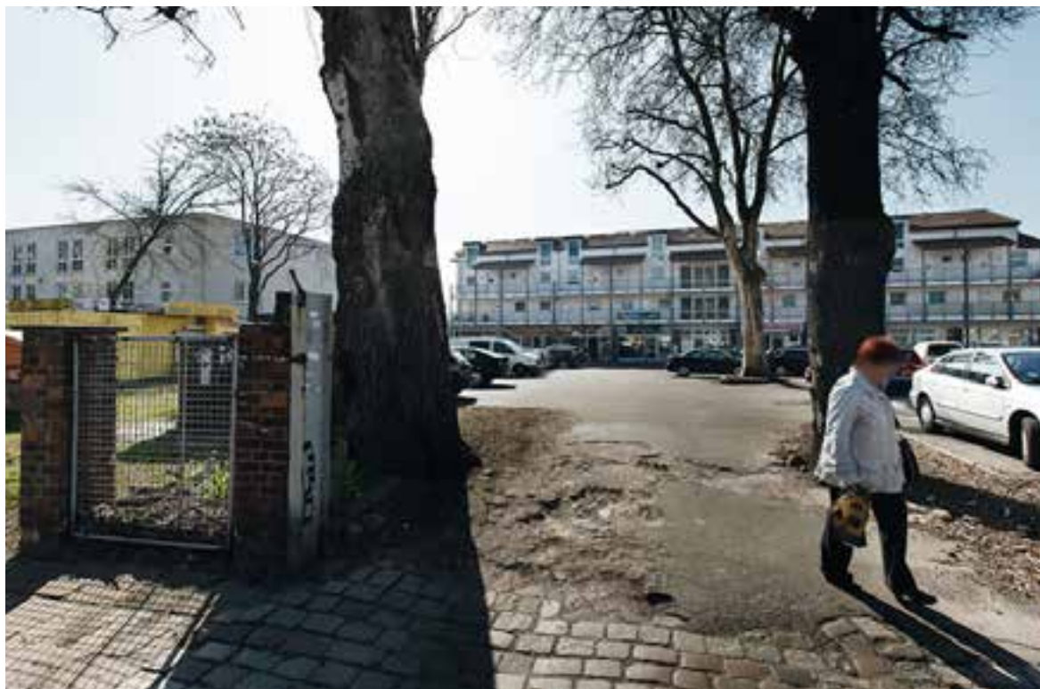
Abbildung 89: fehlende Grundstückseinfriedung/beschädigte Oberflächen am Nahversorgungszentrum Große Diesdorfer Straße
