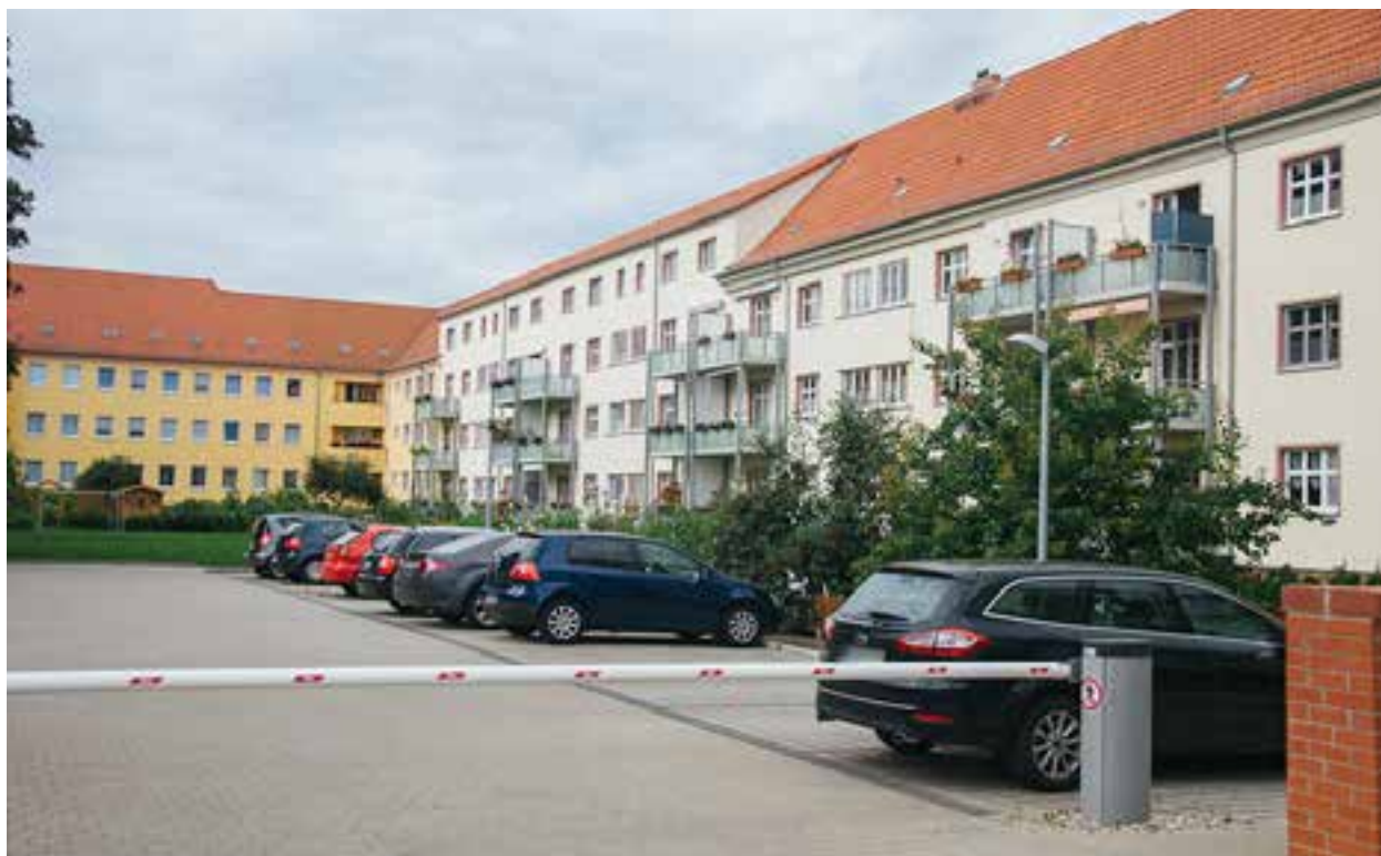
Abbildung 16: neu geschaffene Stellplätze in der Friedrich-Naumann-Straße in Stadtfeld Ost
