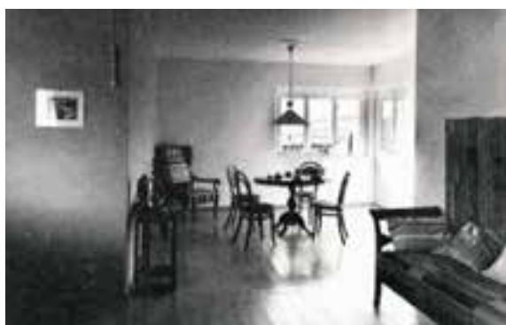
Abbildung 84: oben, Hermann-Beims-Siedlung Abbildung 85: links, historische Aufnahme einer Wohnung in der Hermann-Beims-Siedlung
