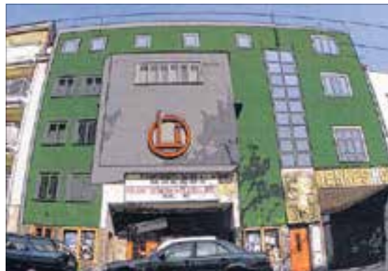
Eigentlich hätte die Fassadensanierung des OLi-Kinos bereits starten sollen. Doch Streitigkeiten mit einem Nachbarn und wiederholte Beschwerden wegen Ruhestörung behindern die Ausführung.
