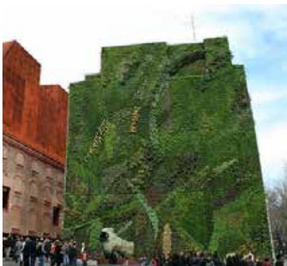
Abbildung 97: Beispiel einer begrünten Brandwand
