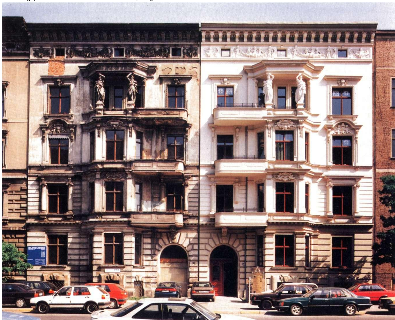
Sanierungsprozess im Südlichen Stadtzentrum, Hegelstrasse 29/30
