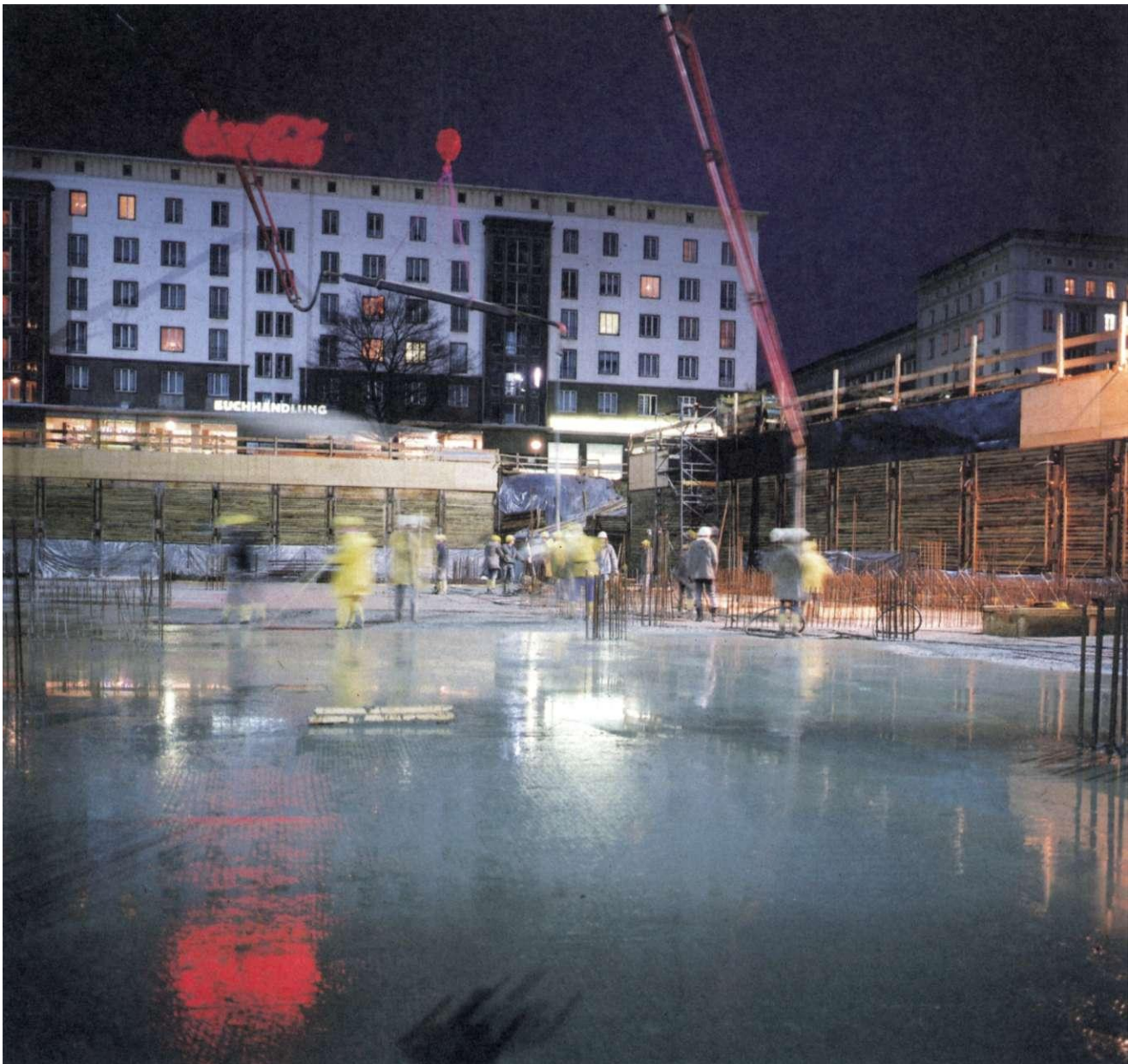
Einbringung des Betons in die Schalung der Bodenplatte (Ulrichshaus - Nachtaufnahme)
