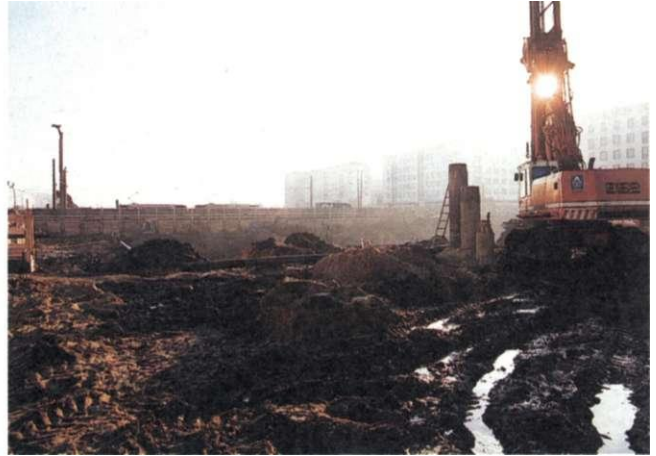
Baubeginn am Ulrichshaus
