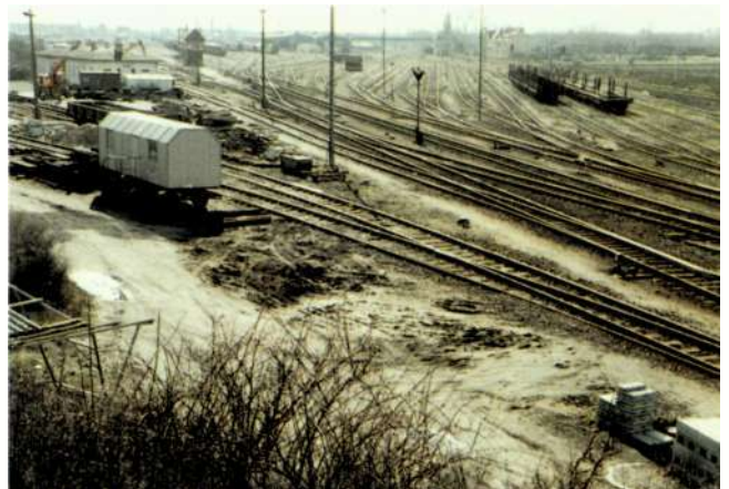
Gleisanlagen bei Rothensee
