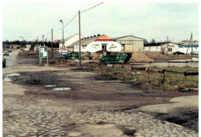
Westerhüsen/Welsleber Straße, heute desolate Gewerbebetriebe
