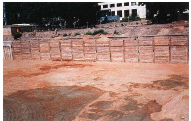
Auf der Baugrubensohle ist tertiärer Grünsand aufgeschlossen
